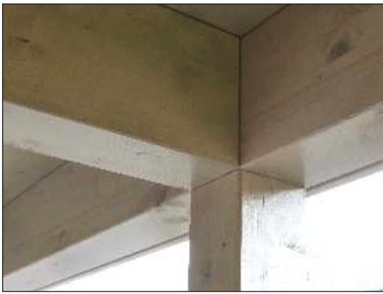
Quer- und Längspfetten mit verdeckten Holzverbindern an Stütze angeschlossen
