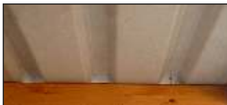
Trapezblech mit unterseitigem Antikondensvlies
