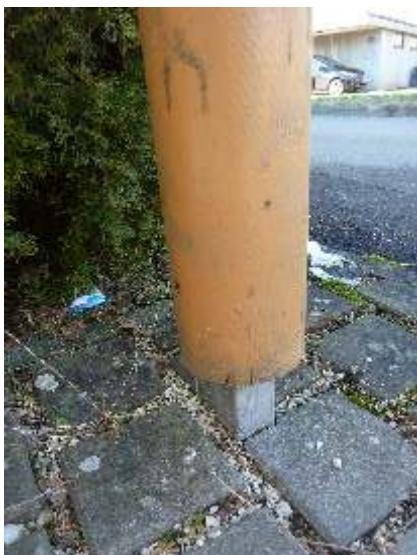
Rundstütze mit Stützenfuß zum einbetonieren
