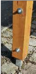
Stützenfuß einbetoniert
