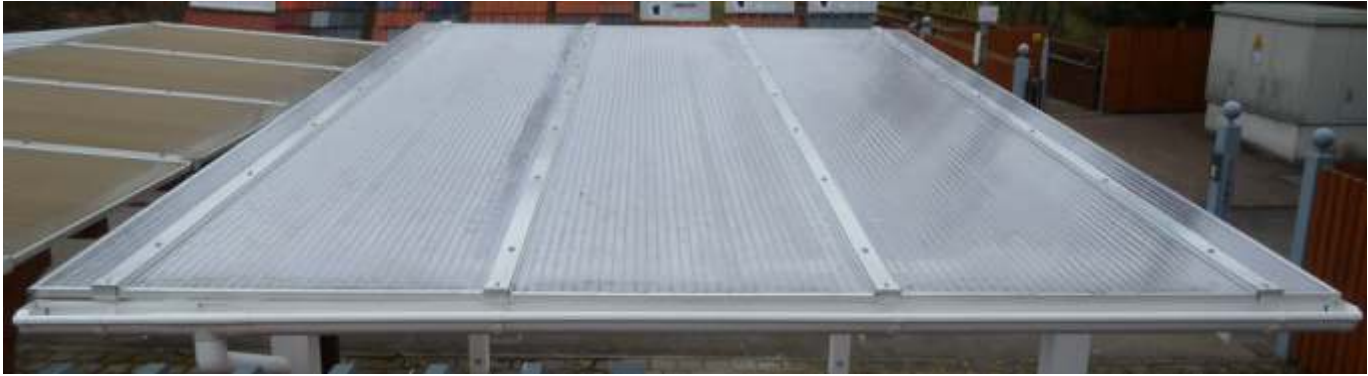
Stegdoppelplatten hell oder getönt, mit Alu-Profilen und Edelstahlschrauben auf Sparren befestigt
