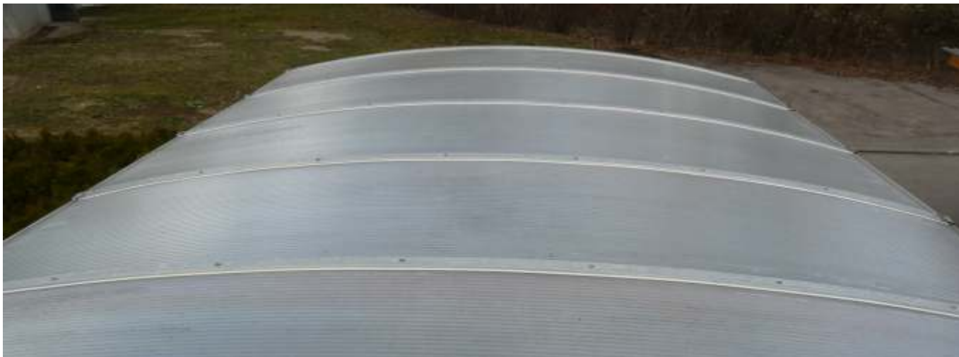
Stegdoppelplatten hell oder getönt, mit Alu-Profilen und Edelstahlschrauben auf Sparren befestigt
