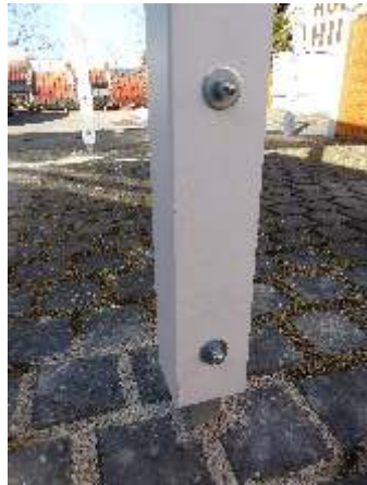
Stützenfuß einbetoniert
