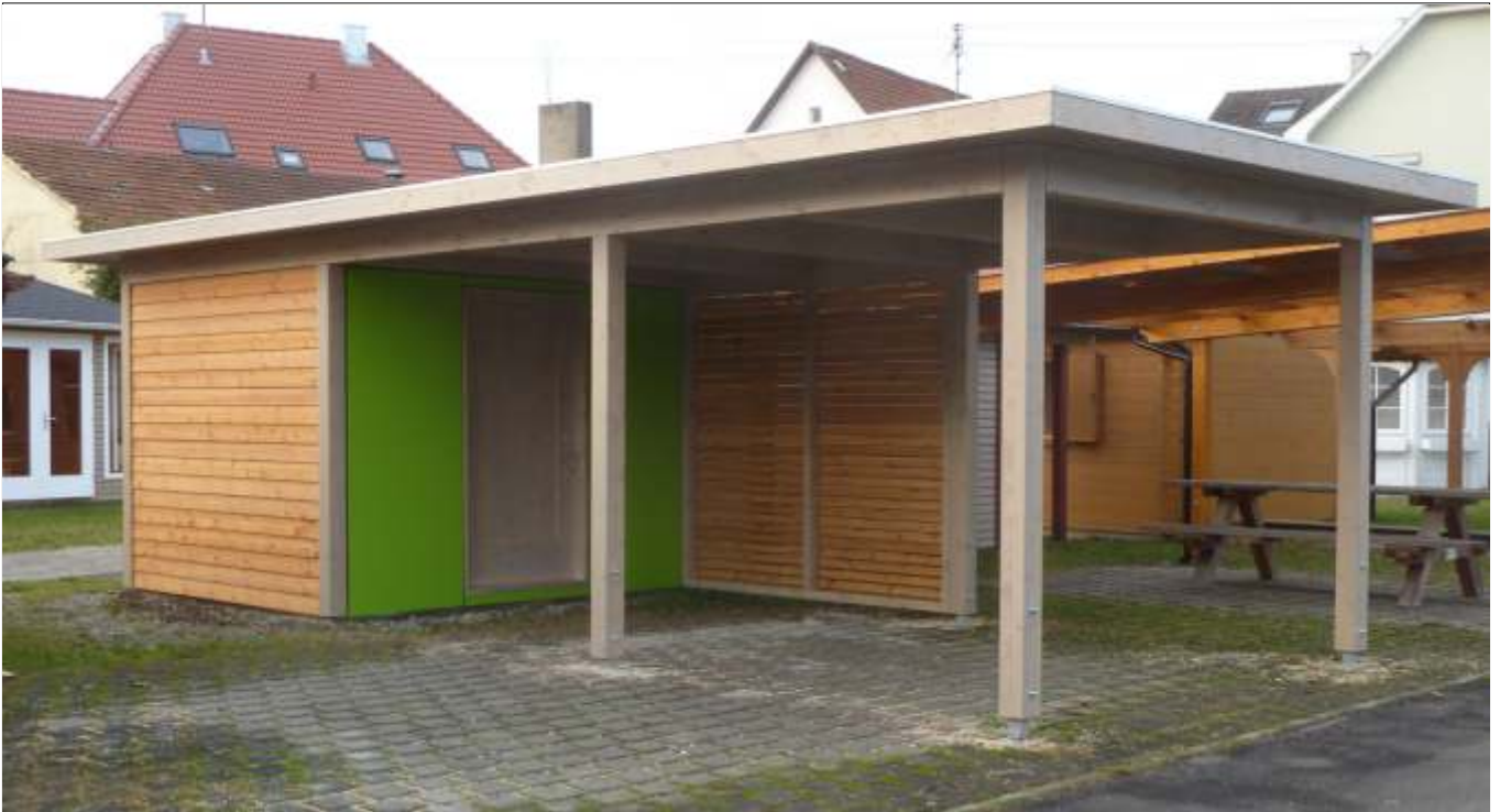
Carport mit Flachdach und eingebautem Geräteraum und Schiebetür. 1 Feld mit Sichtschutzelement aus Rhombusleisten
