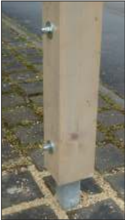
Stützenfuß einbetoniert
