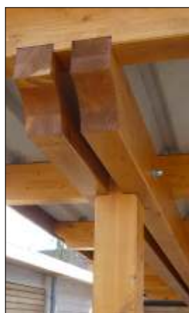
Doppelzangen mit Stütze
