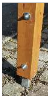
Stützenfuß einbetoniert
