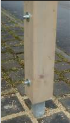
Stützenfuß einbetoniert
