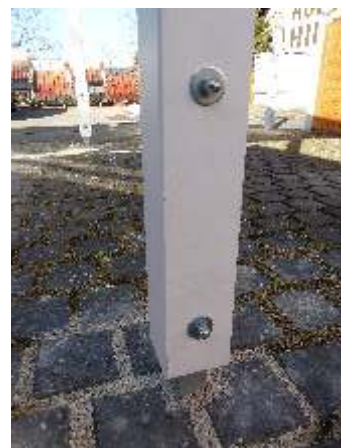
Stützenfuß einbetoniert
