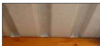
Trapezblech mit unterseitigem Antikondensvlies
