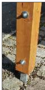
Stützenfuß einbetoniert
