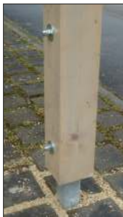
Stützenfuß einbetoniert
