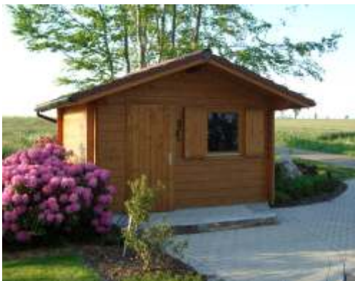
Blockhaus Typ G 36 A 30 Wandstärke 46mm
