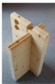
Eckverbindung Blockhaus
