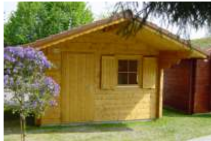
Vordach an Giebelseite
