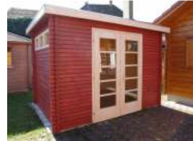
Flachdach mit Teichfolie
