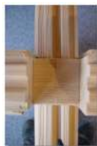
Eckverbindung Blockhaus
