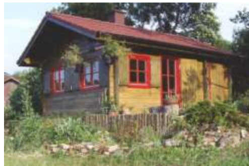
mit Heizung (Schwedenofen)
